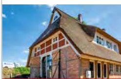
Sanierung und Umbau
